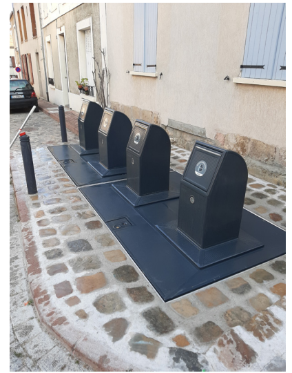
Enfouissement des conteneurs place du Change en 2021
