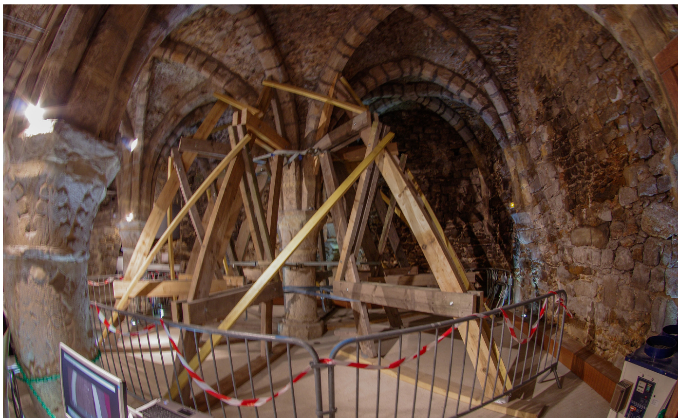
Réfection d'un pilier et reprise des enduits des Pressoirs en 2017
